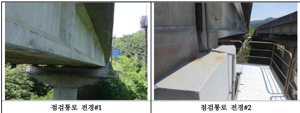
【사진 3.25】 교량 점검시설 전경
