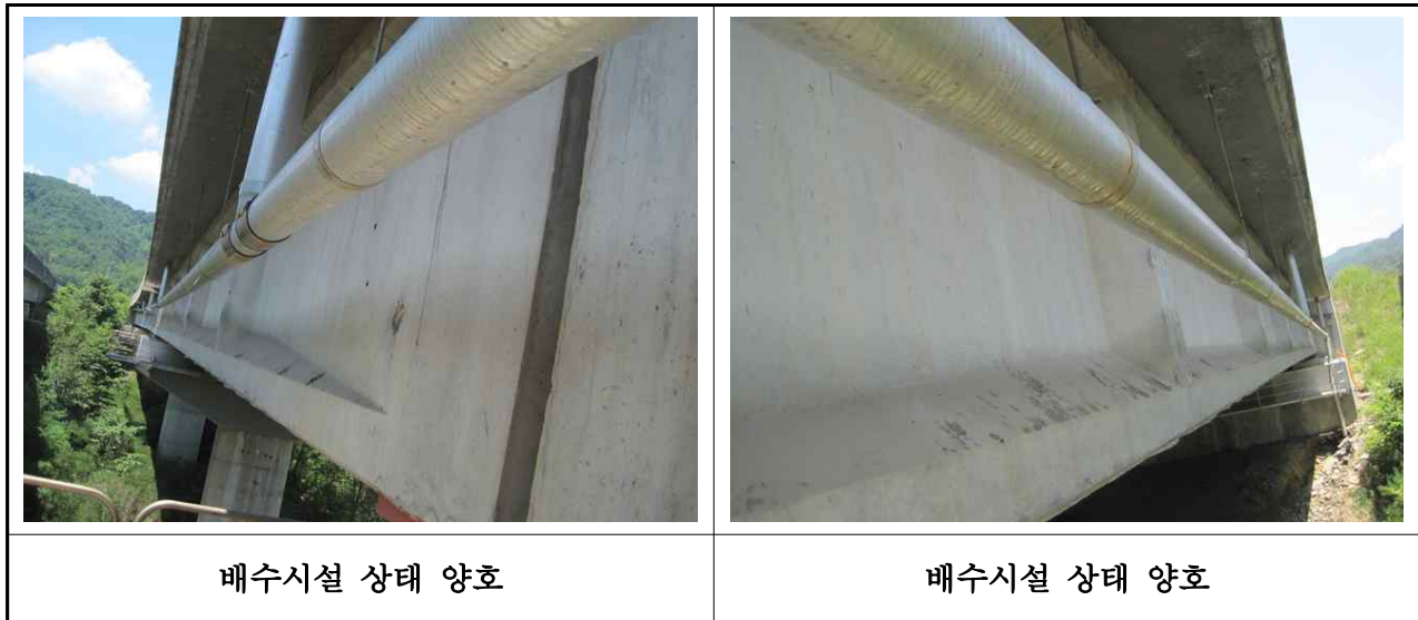
【사진 3.22】 배수시설 손상현황
