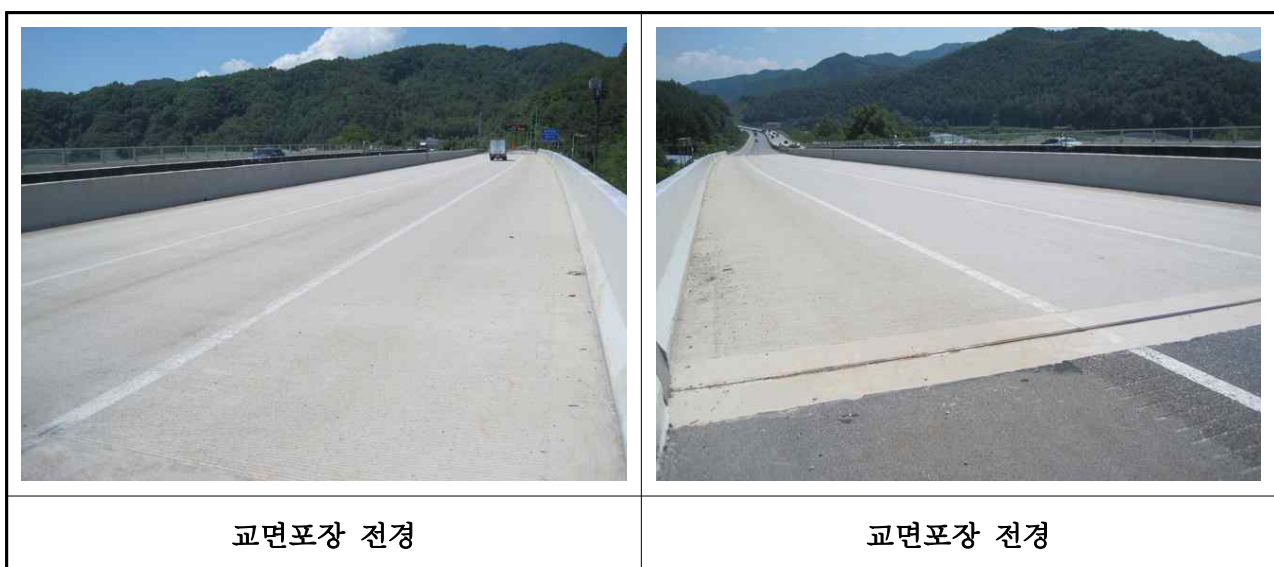
【사진 3.19】 교면포장 전경
