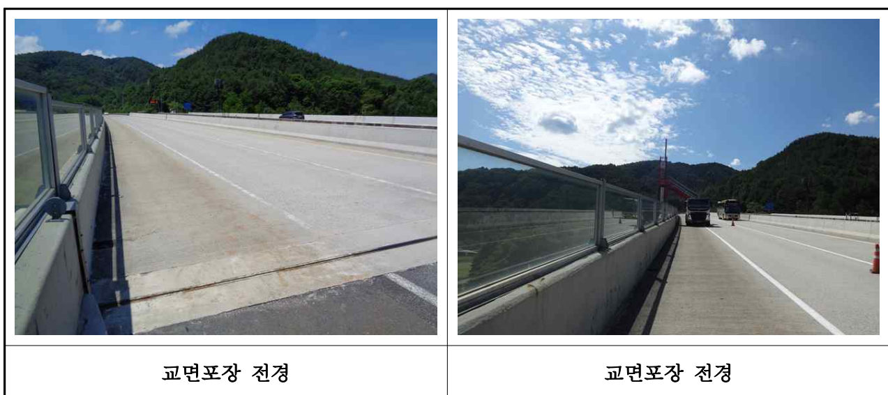
【사진 3.44】 교면포장 전경
