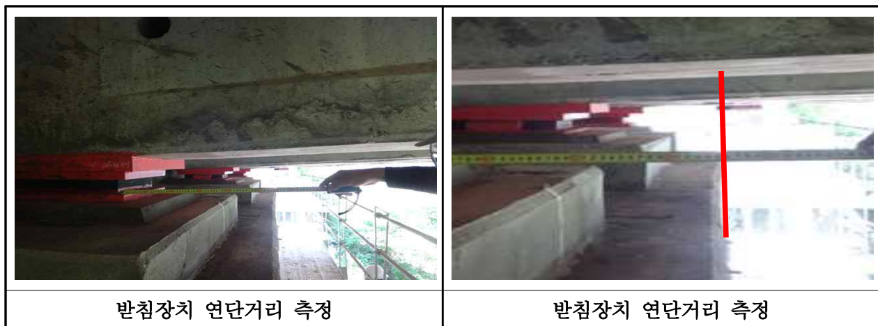
【사진 3.39】 교량받침장치 연단거리측정
