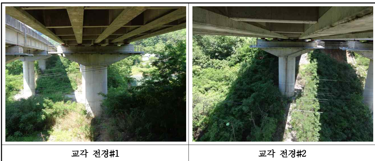
【사진 3.10】 교각 전경
