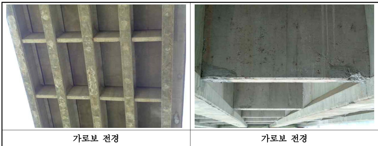
【사진 3.31】 가로보 전경
