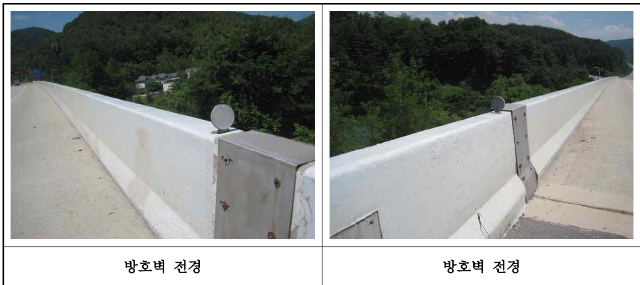
【사진 3.23】 방호벽 및 중앙분리대 전경
