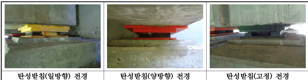
【사진 3.37】 교량받침 전경
