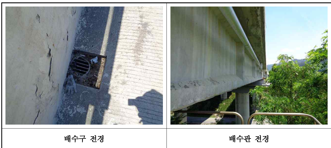
【사진 3.46】 배수시설 전경
