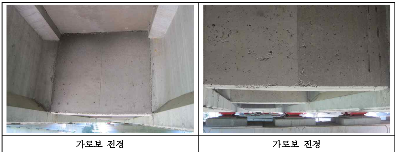
【사진 3.6】 가로보 전경
