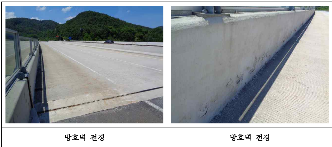
【사진 3.48】 방호벽 및 중앙분리대 전경
