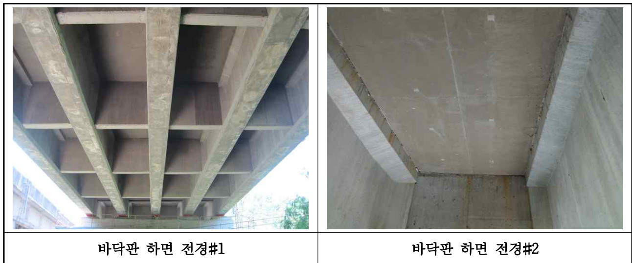
【사진 3.2】 바닥판하면 전경
