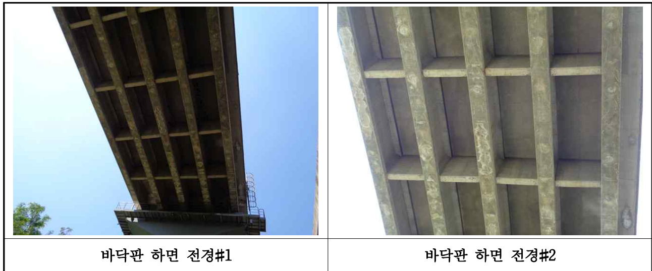
【사진 3.27】 바닥판하면 전경
