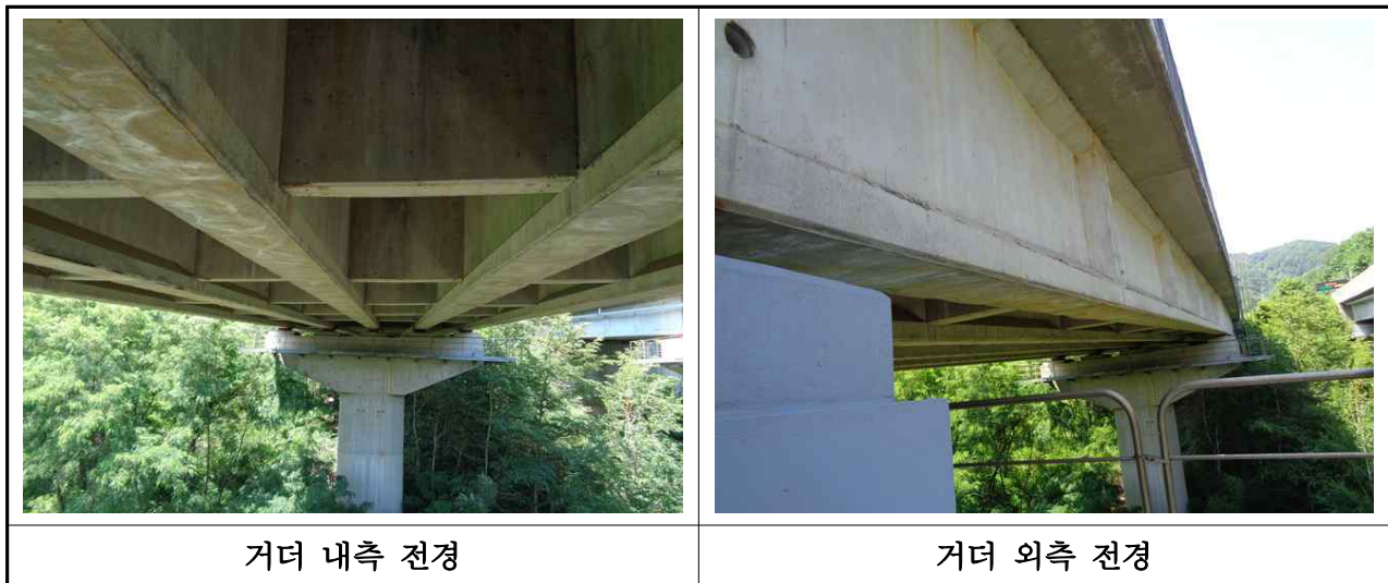
【사진 3.29】 거더 전경
