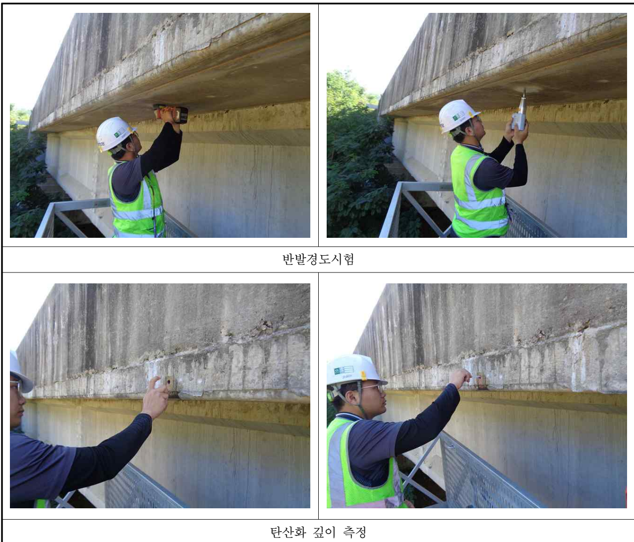
【사진 3.52】 콘크리트 내구성조사 현황
