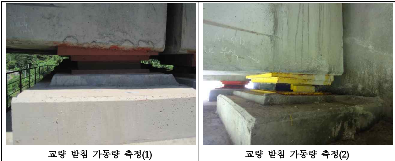
【사진 3.15】교량받침 이동량 측정
