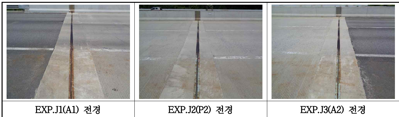
【사진 3.41】 신축이음장치 전경
