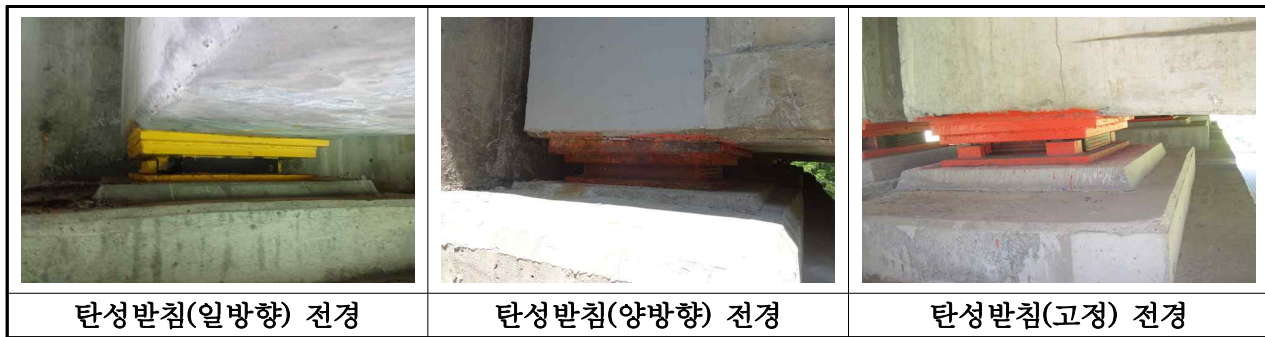
【사진 3.12】 교량받침 전경
