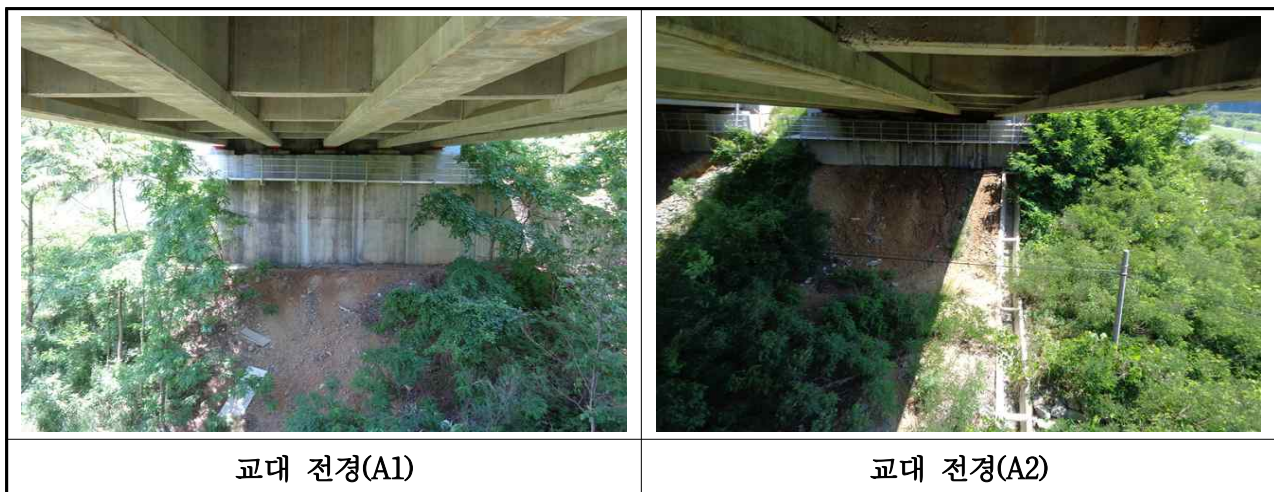
【사진 3.33】 교대 전경
