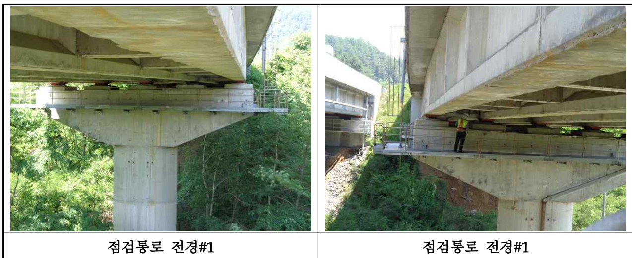
【사진 3.50】 교량 점검시설 전경
