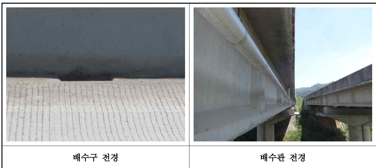
【사진 3.21】 배수시설 전경
