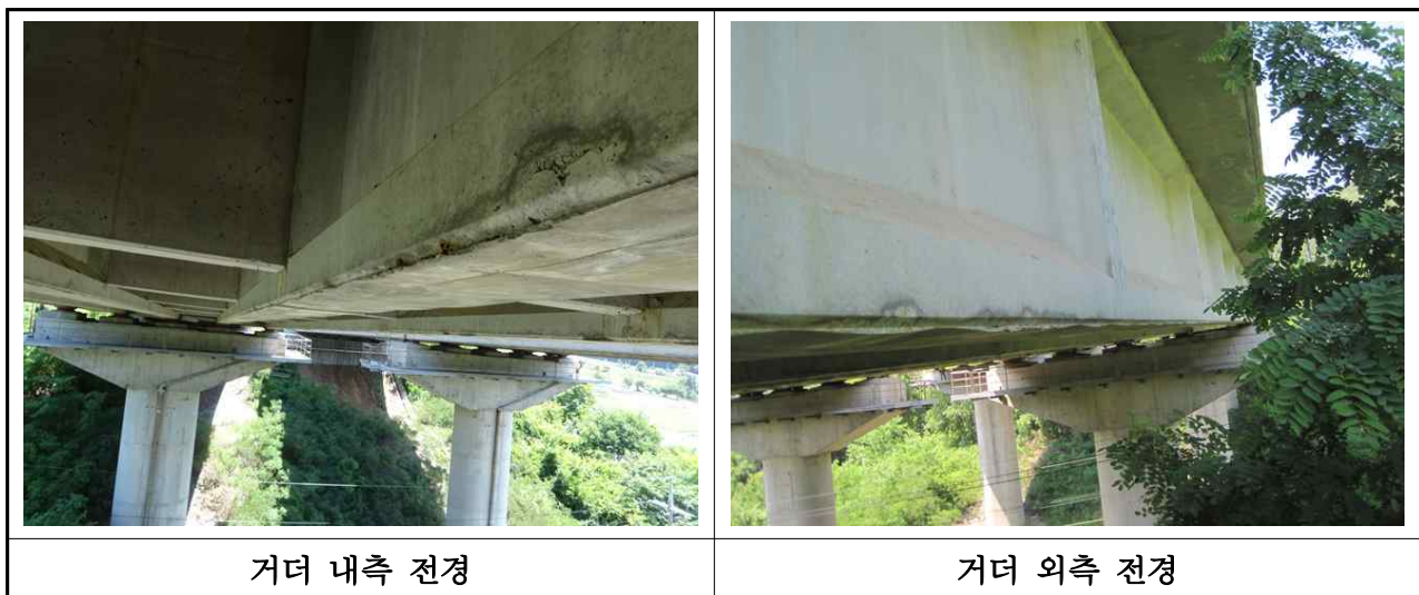
【사진 3.4】 거더 전경
