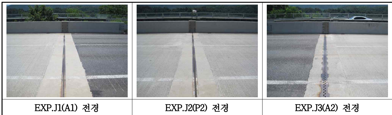
【사진 3.16】 신축이음장치 전경
